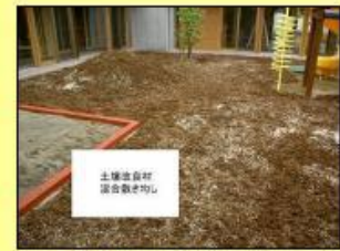
土壌改良材混合敷き均し
